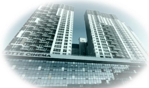
동작 협성포레 대형상업시설 침수
